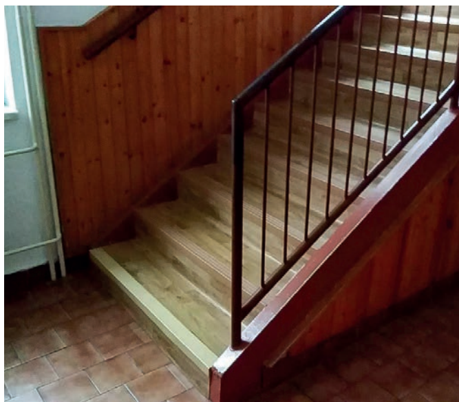
Schodiště- současný stav
