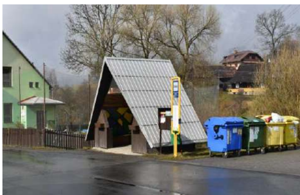
Autobusová zastávka před rekonstrukcí
