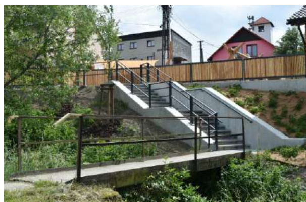
Nový přístup od lávky
