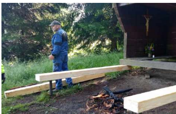
Byla obnovena odpočívka „U Trafa“.
