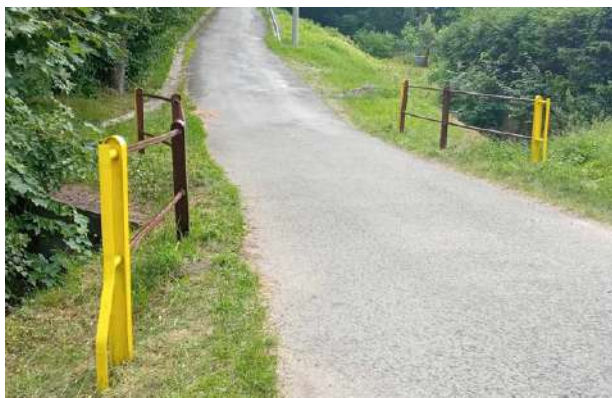
Probíhají nátěry zábradlí na propustcích, lávkách a mostech.
