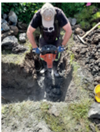
Oprava překopu vodovodního řádu
